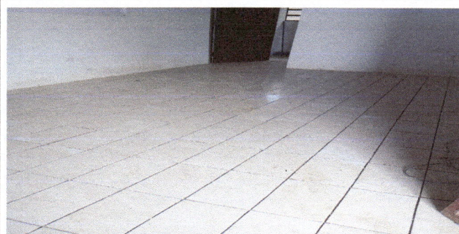
Foto 5: Culminacion de cambio de piso torta de cemento a piso ceramico.
