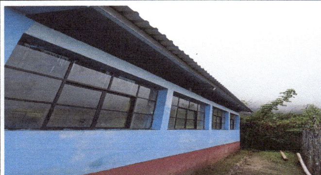
Foto 1: culminacion de cambio de estructura de madera a estructura metálica.
