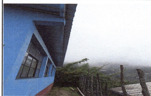
Foto 6: Sustitución de canal de pvc a canal metálico galvanizado con pescantes.
