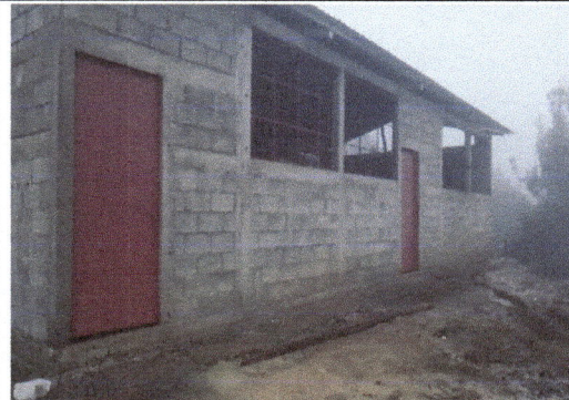
Foto 2: Culminacion de cambio de láminas acanaladas a láminas troqueladas calibre 26.
