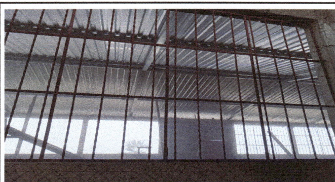
Foto 3: Culminacion de cambio de ventanas a ventana balcon aula.
